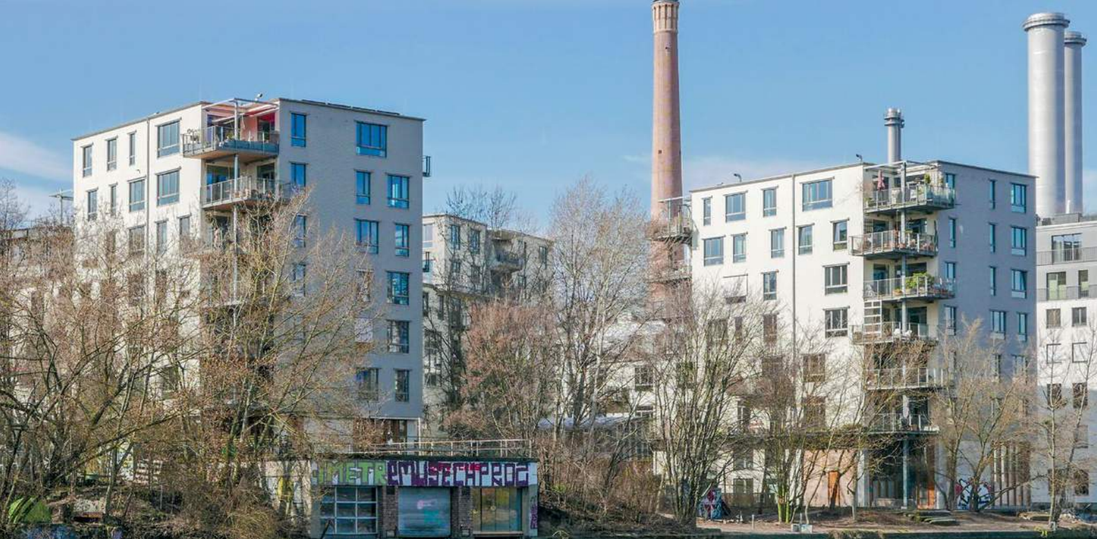
Abb. 14: Wasserseite von Haus 3 (links), Haus 1 (Mitte) und Haus 2 (rechts) mit Bootshaus
