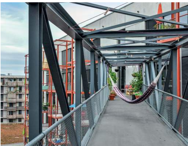
Abb. 57: Brücke zwischen den Gebäuden im 5.OG
