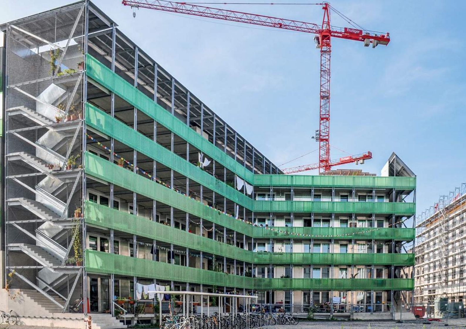
Abb. 70: StadtErle, Hof-Fassade mit sichtbarer Außenerschließung
