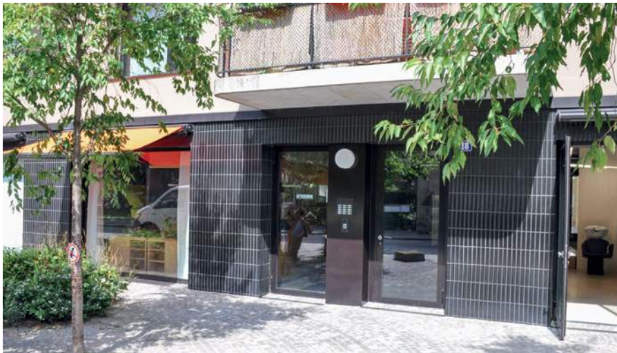
Abb. 35: Hauseingang und Gewerbeeingänge im EG
