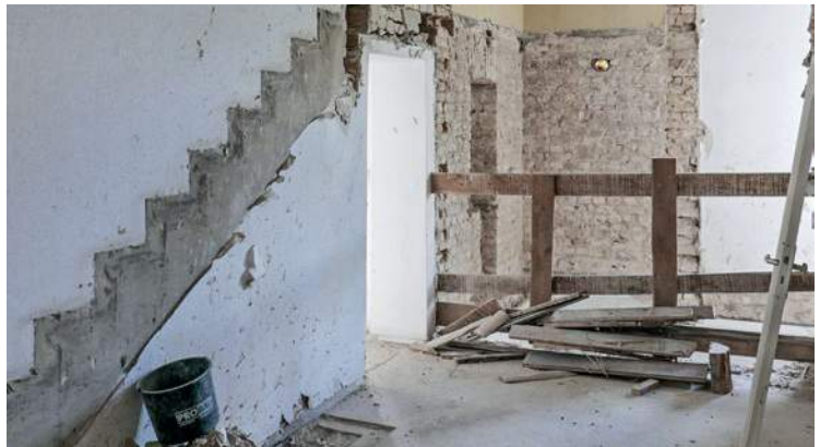
Abb. 83: Weitreichende Umbauarbeiten für ein neues Treppenhaus
