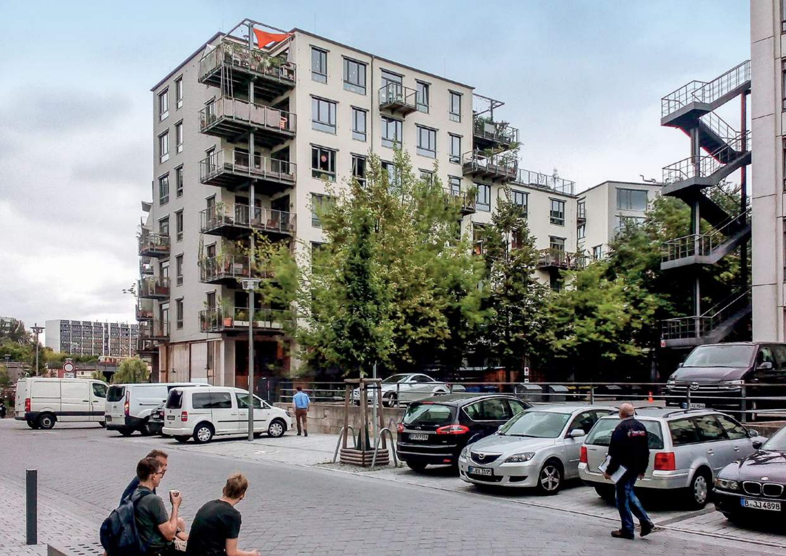
Abb. 8: Spreefeld Straßenseite, Blick auf Haus 2
